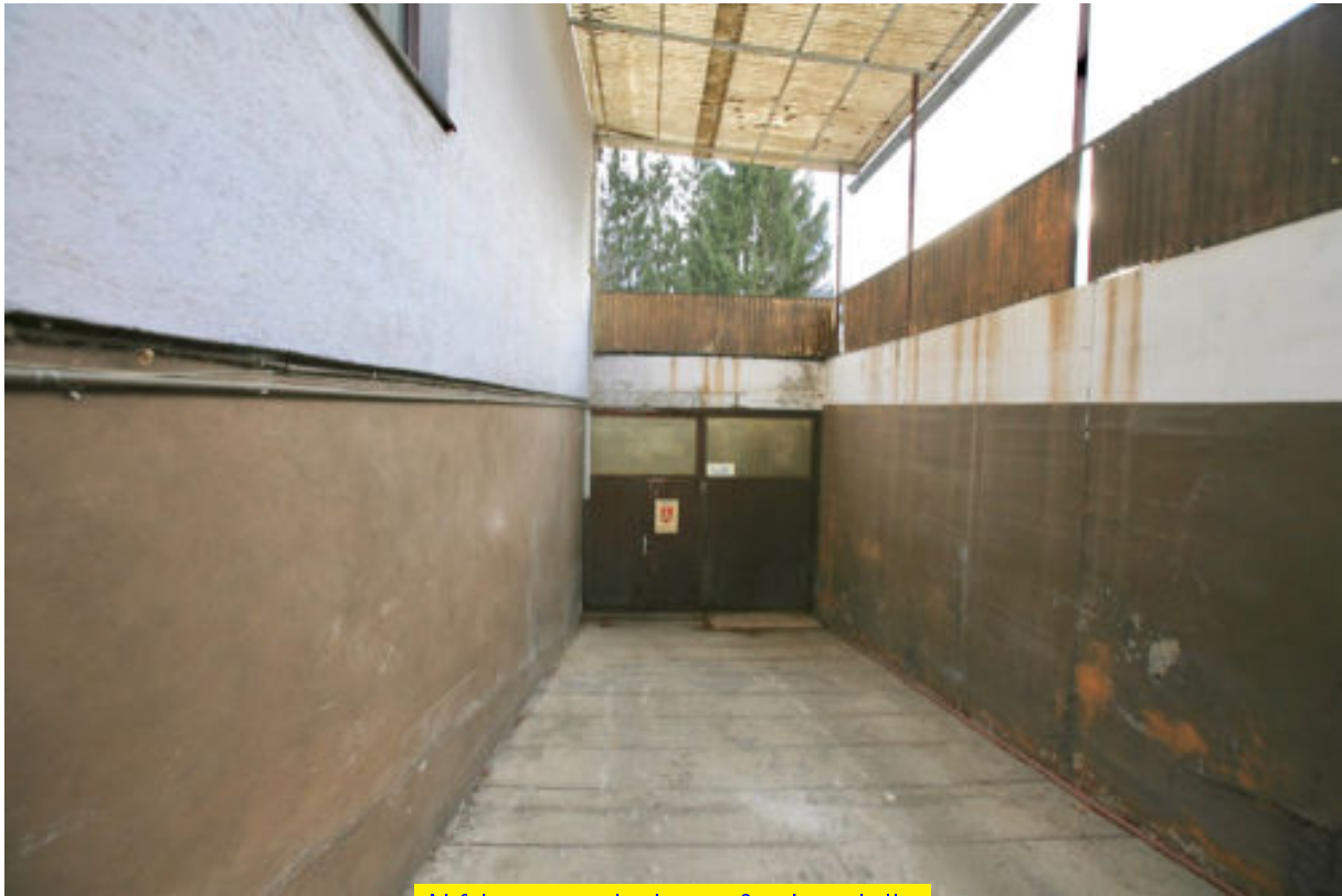
Abfahrtsrampe in den großen Lagerkeller
